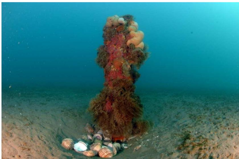
**Photo 82 : Dépression sédimentaire à la base d'un poteau métallique**
